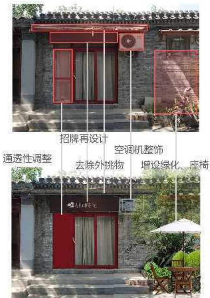
综合整改范例2
