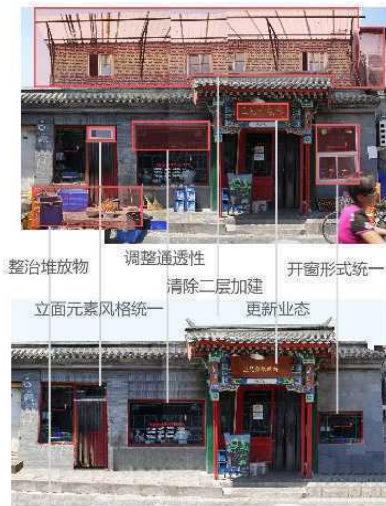
综合整改范例3
