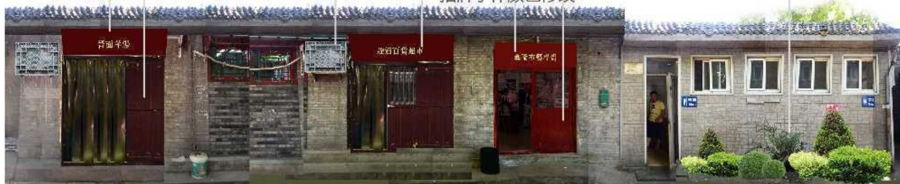
综合整改范例1
