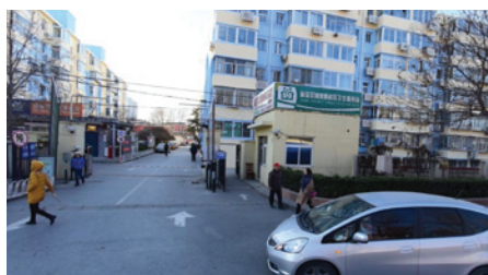
图12 城建四社区现状照片（图片来源：百度地图街景）
