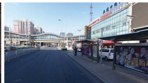
图10 五道口地铁站现状照片 (图片来源: 百度地图街景)
