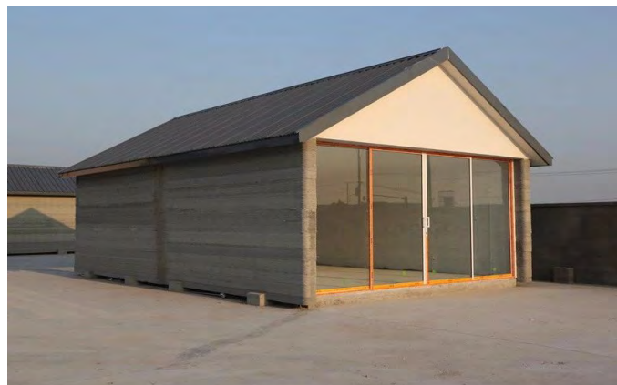
▲ 用建筑垃圾一天打印10栋房屋
