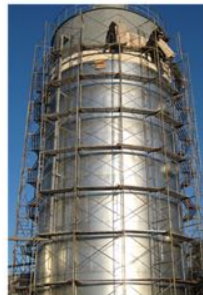
罐体液位检测
