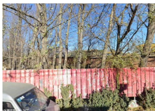
3.4 施工围挡污损
