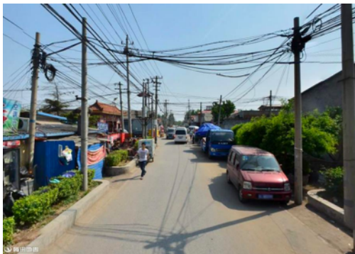
5.1 基础设施破损
