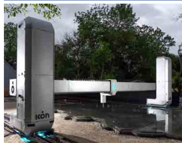
3D打印住宅建造 4
