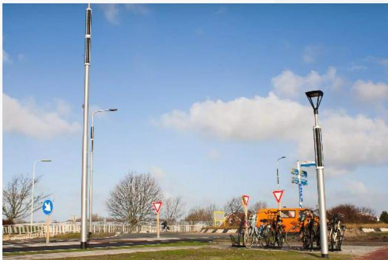
垂直集成的太阳能模块可完全脱离电网运行，无需进行挖沟和铺设电线。此外兼具WiFi热点，USB充电点等功能。
