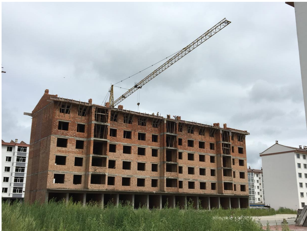
正在新建的多层居住区 伊春市翠峦区（现乌翠区），2016
